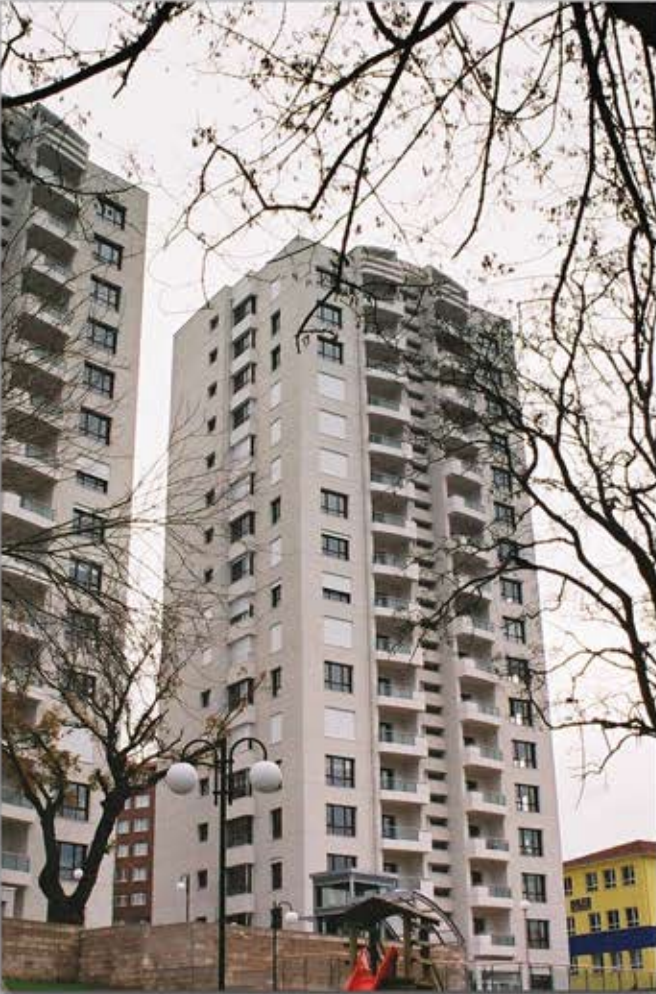
Korkuluk Dikmeleri Konut Sitesi-İSTANBUL
